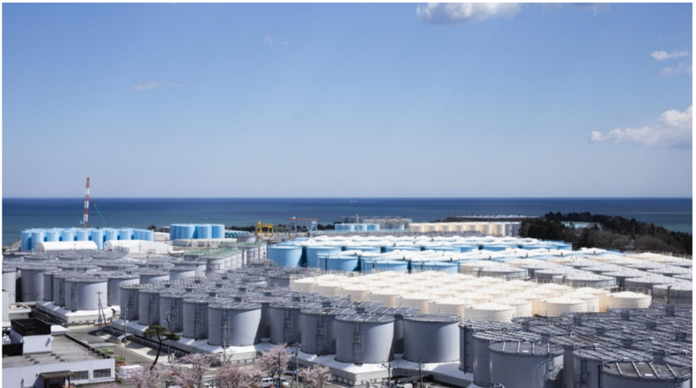
Réservoirs d'entreposage des effluents radioactifs à la centrale nucléaire de Fukushima Daiichi © TEPCO
